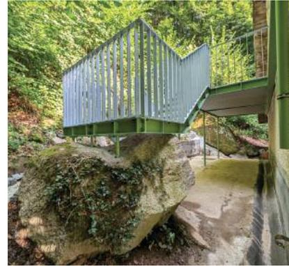
Der Findling auf dem Gelände wurde kunstvoll in die Konstruktion der Fluchttreppe integriert.
